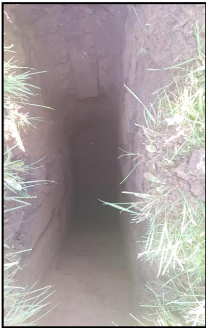
BRE 365 TEST HOLE
