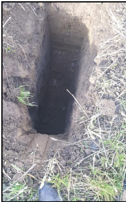
BRE 365 TEST HOLE
